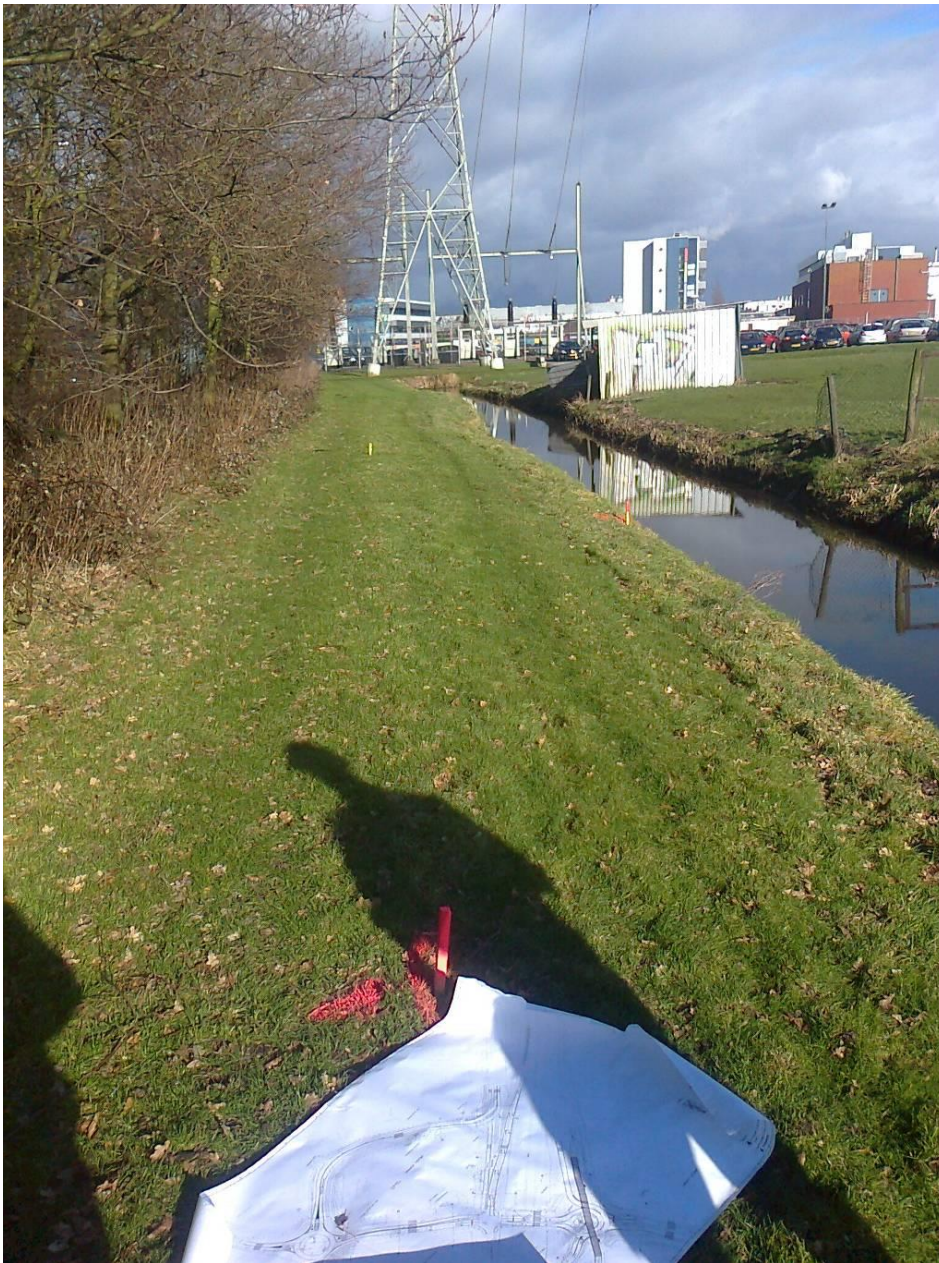
Afbeelding 1.1 foto van de gewenste locatie van de proefsleuf genomen in noordoostelijke richting, 8 februari '13; de hier nog aanwezige bossage (links) is op 21 februari '13 verwijderd, waarna het gravend onderzoek kon plaatsvinden; vergelijk uiteindelijke opengetrokken sleuf in afb. 2.1 - foto: Grontmij.
